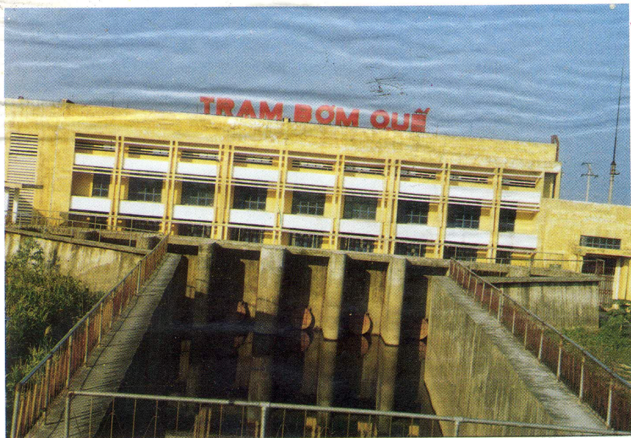
Trạm bơm trực đứng Quế (Kim Bảng) Khánh thành năm 1993
